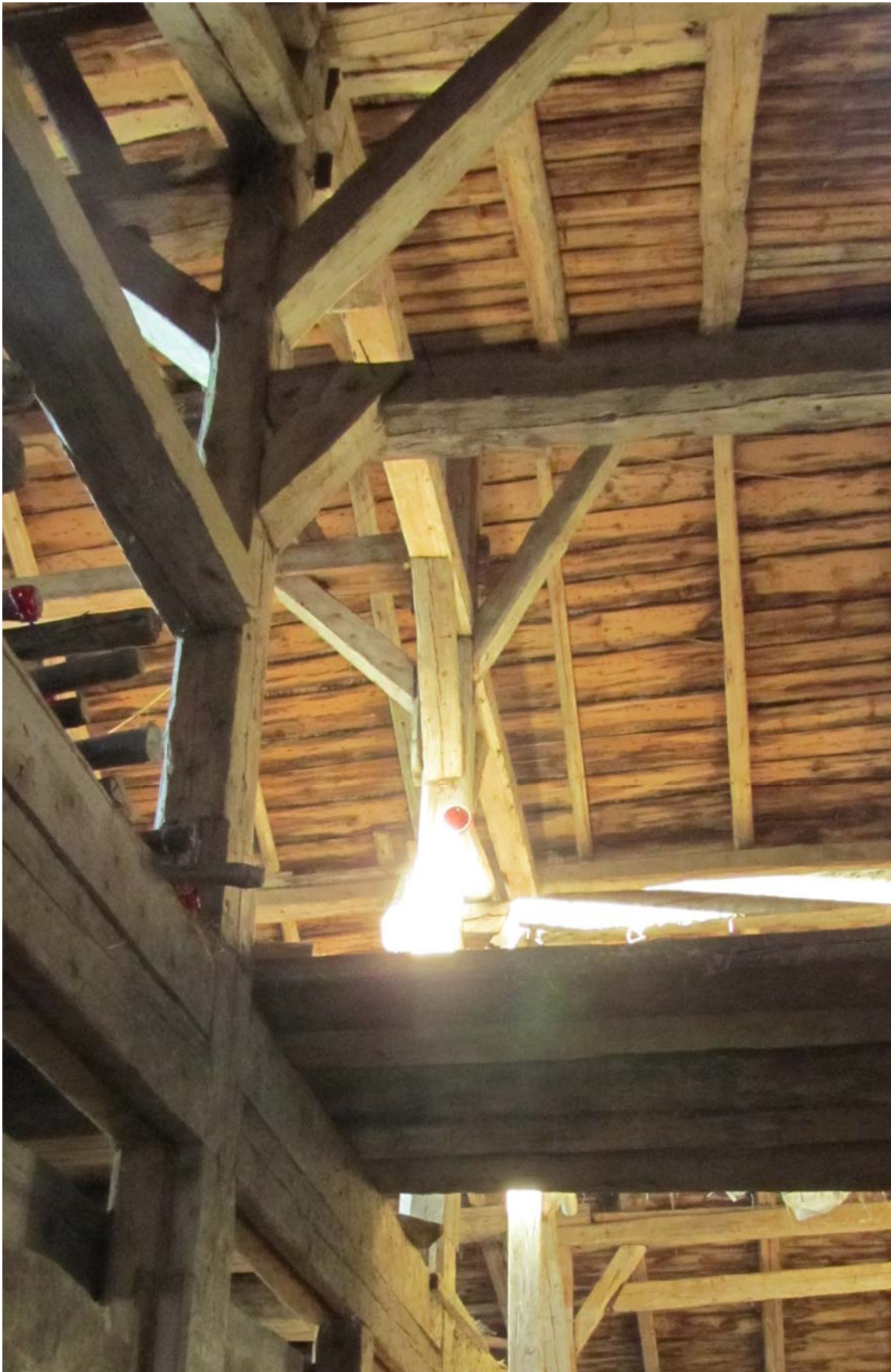
La poutraison est incontestablement belle.
